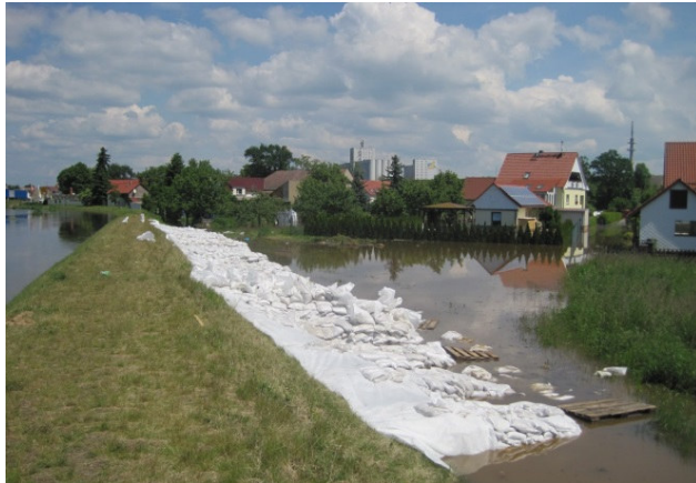
Foto 5 - Deichsicherung mit Sandsäcken [LfU, 2013]
